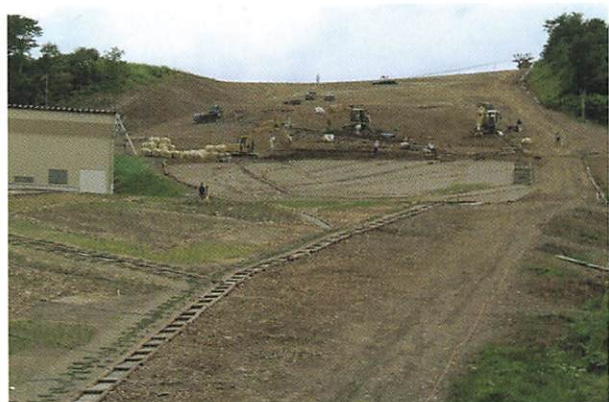
写真 1. 造成中の植物園
