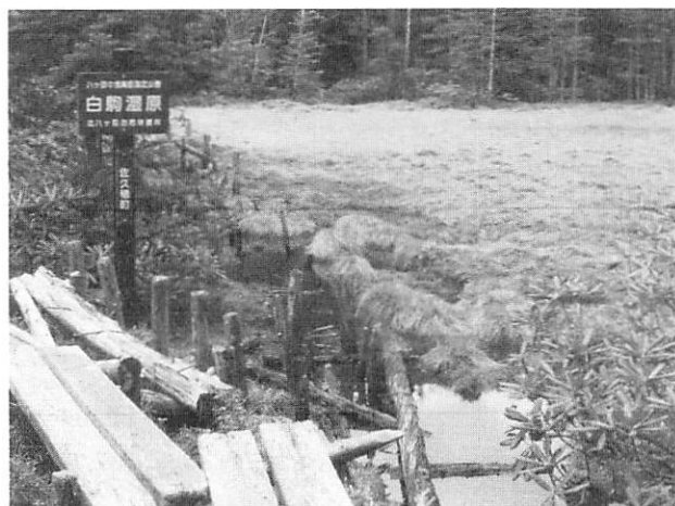
写真1 湿原の入り口 木道と湿原の境に池塘がみられる。
