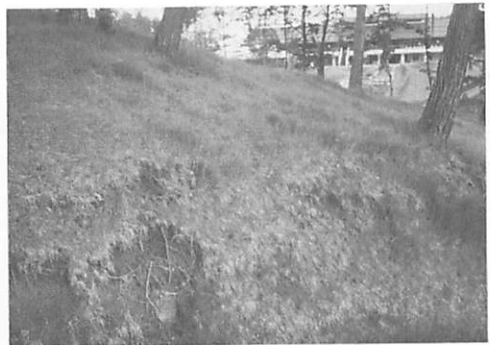
写真一 5 急斜面の法面は緑化が進みにくく、 ここも管理が必要
