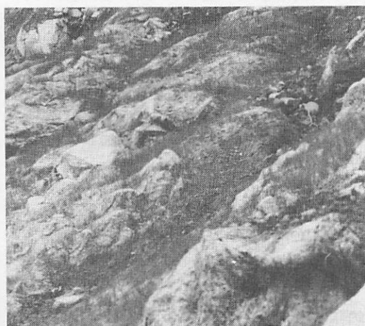
最近の崩壊面の復元方法（白山における砂防例）
